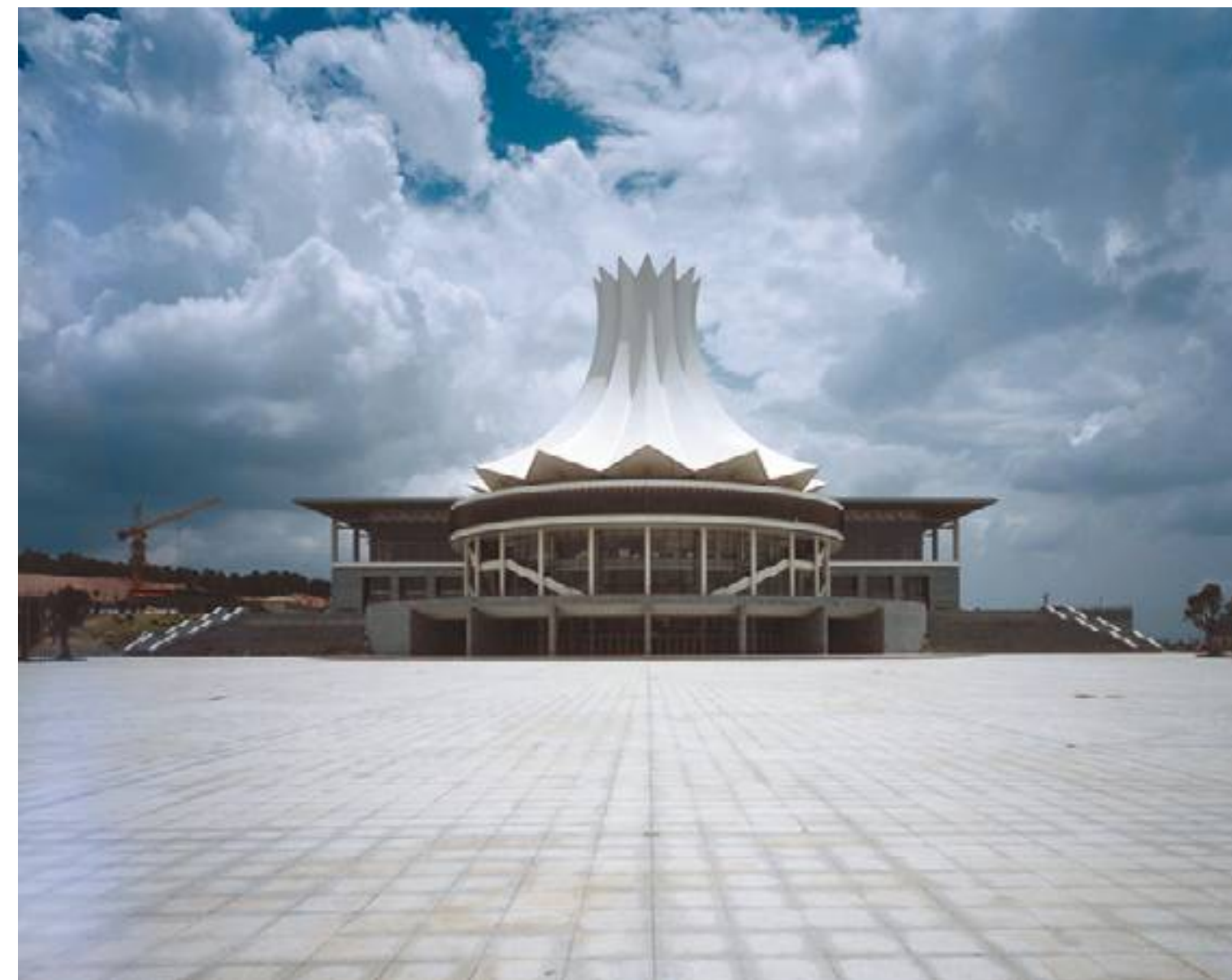
Vista della rotunda dalla piazza di accesso. Nella pagina a fianco dal basso: piante ai livelli di ingresso, primo e secondo.
