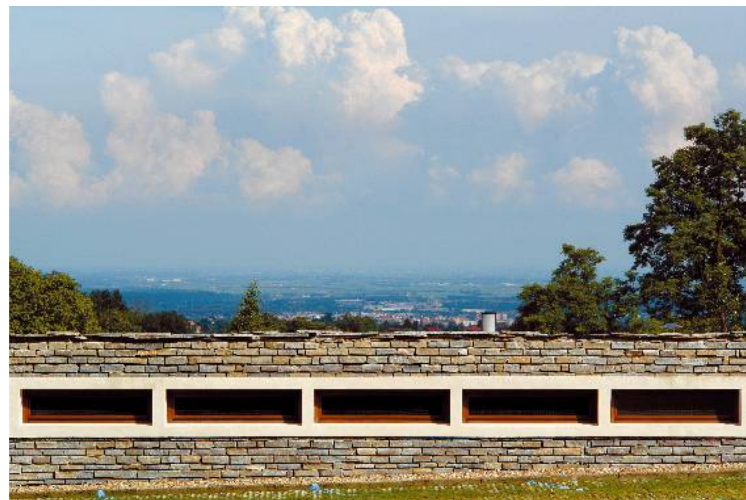
Particolare del muro di pietra di Luserna, fronte nord.
