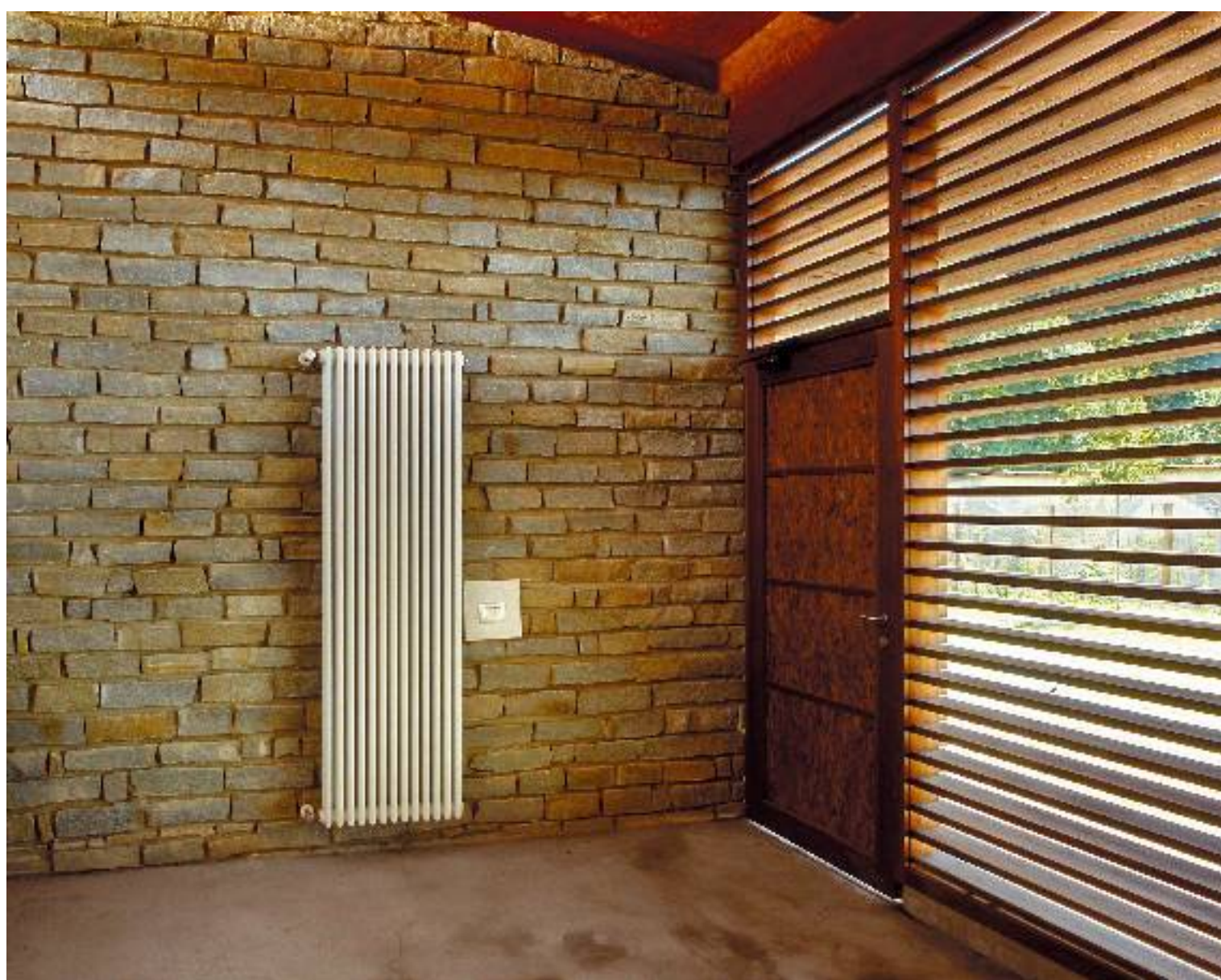
Particolare del “graticciato” di legno della zona lavanderia.
